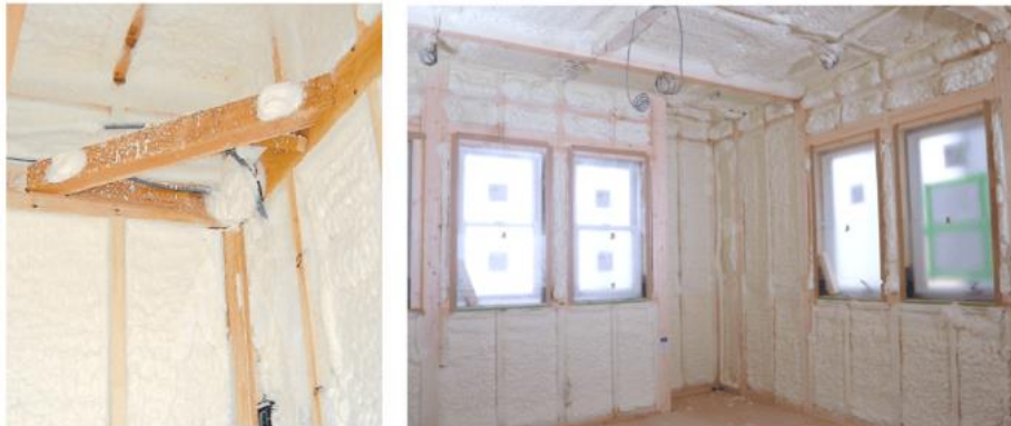
現場吹付発泡断熱材「アクアフォーム」施工イメージ
