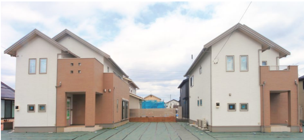
ヒノキヤグループ 検家住宅 実験棟外観（栃木県那須塩原市）
